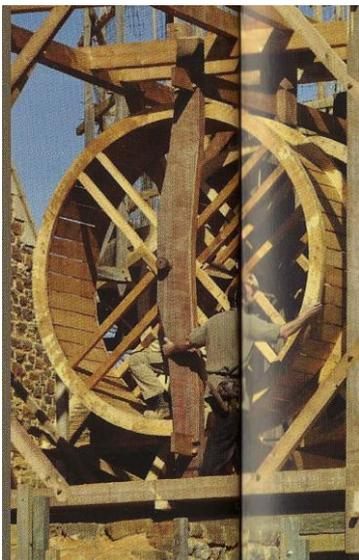
Pas de trax ni de grue sur ce chantier, mais la force tranquille des chevaux, celle des bras des ouvriers ou celle des jambes dans les « cages à écureuil » !.Ci-contre, une impressionnante représentation de ce moyen de levage dont un magnifique exemplaire peut être vu à Romont.
